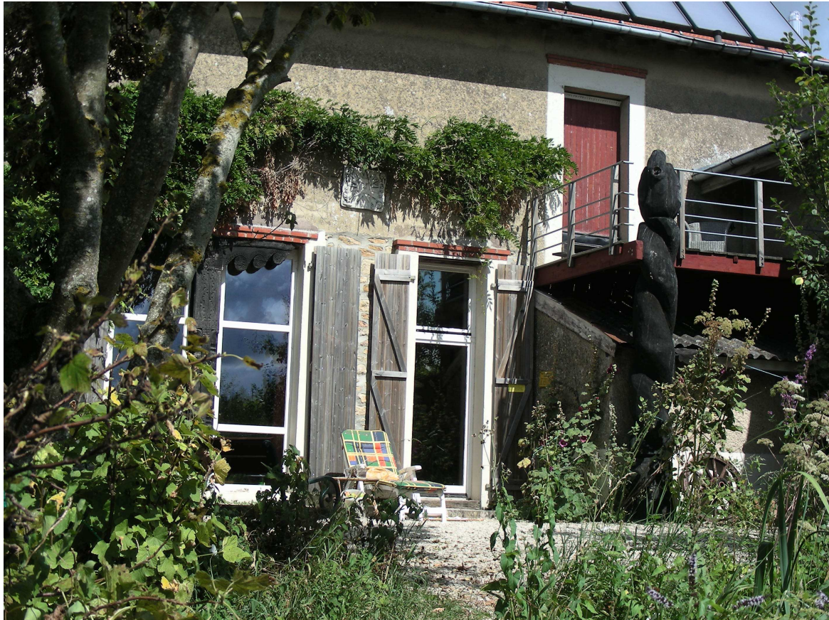
Südseite mit Blick auf Salon, Balkon und Hauptterrasse
